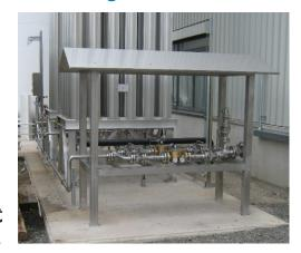
一套冗余解决方案,为 757 系列分别配置一个气囊式气动先导减压阀套件。
